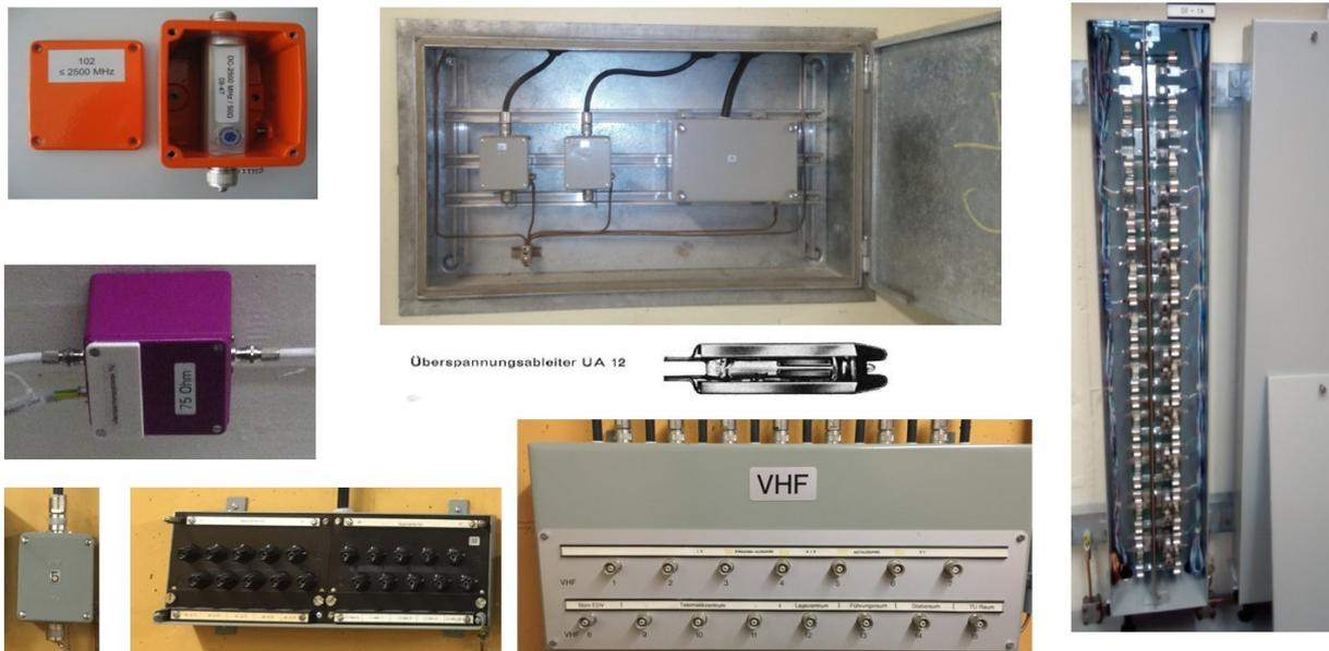
Die Führungsunterstützung soll in einem nächsten Wiederholungskurs (WK) kontrollieren, ob alle Telematik-Einrichtungen mit den nötigen und heute gängigen Überspannungsableitern ausgerüstet sind.
